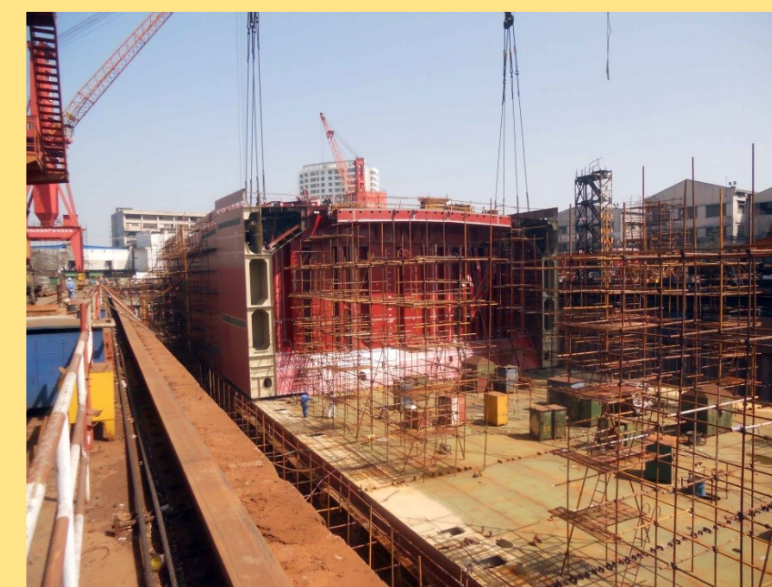
Montaje de bloques en D/Seco
