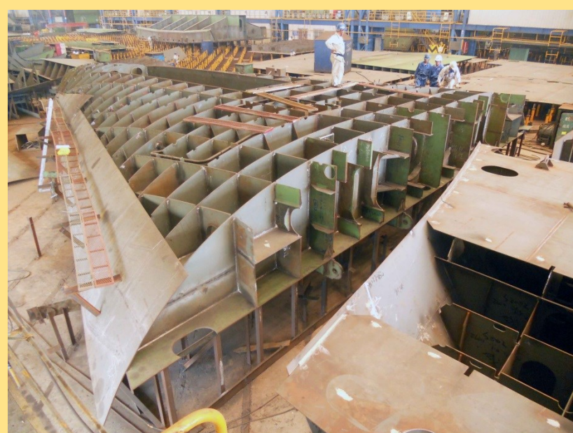
Construcción de secciones y bloques
